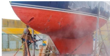
Gambar 2.9 Korosi pada Lambung Kapal
