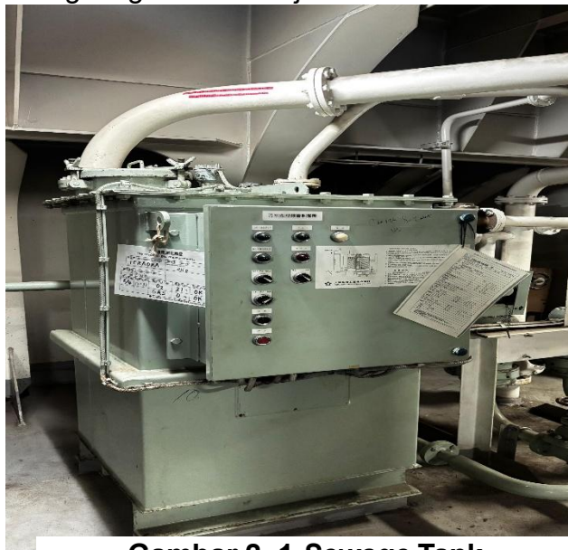
Gambar 2. 1 Sewage Tank Sumber : KM. Mutiara Berkah II
