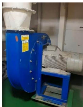
Gambar 2.15. Air Slide Fan
