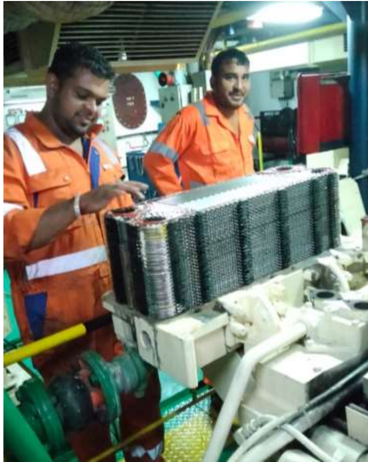
Gambar 3.2 Pemasangan Heat Exchanger
