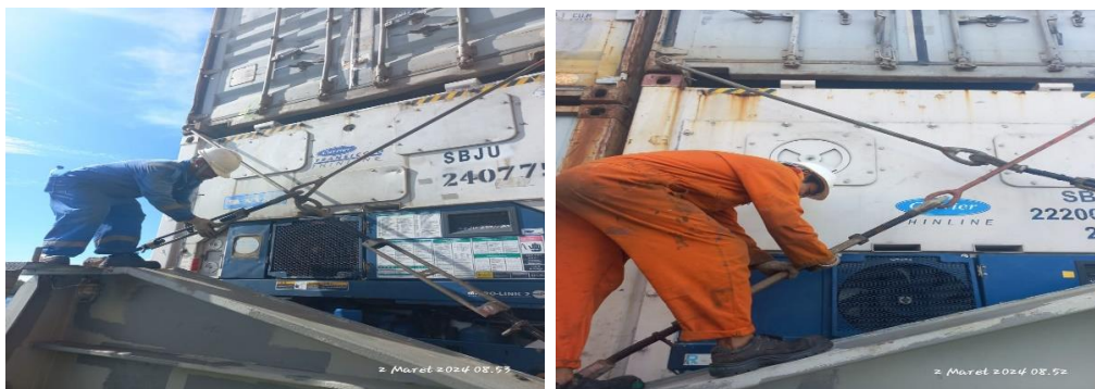
Gambar 4.2 Proses pemasangan dan pengecekan lashing
