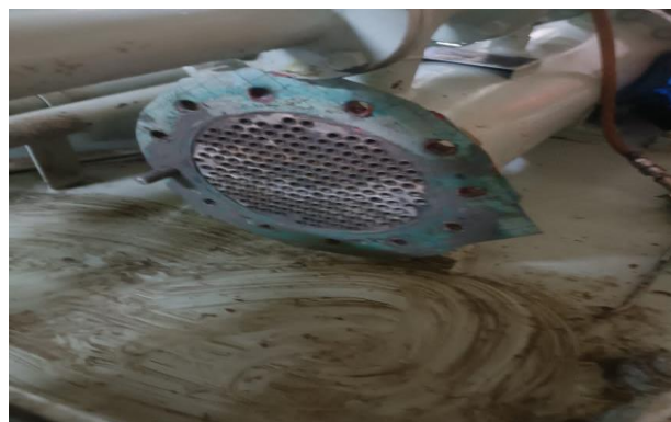
Gbr 12. Kondisi Cooler setelah dibersihkan
