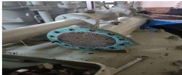
Gbr 11. Kondisi Cooler sebelum dibersihk
