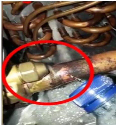
Gambar: 3.3 mencari kebocoran dengan busa sabun AHTS. Atlas Harrier
