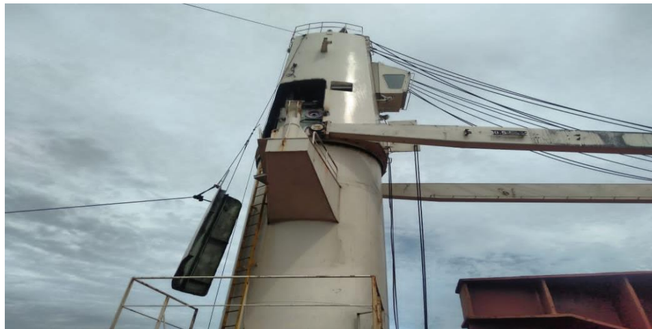
Gambar 4.13 Kerusakan Crane No 2
