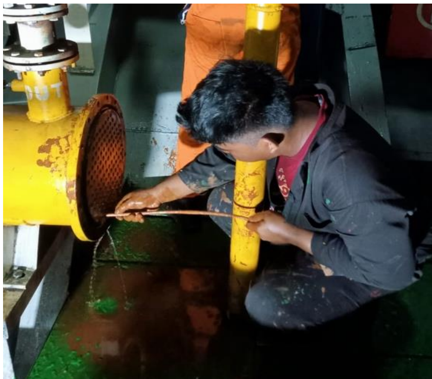
Sumber: Sumber engine room mv landseador 16
