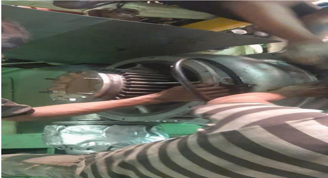
Gambar 11 : Melakukan Pembersihan Pada Turbin Side
