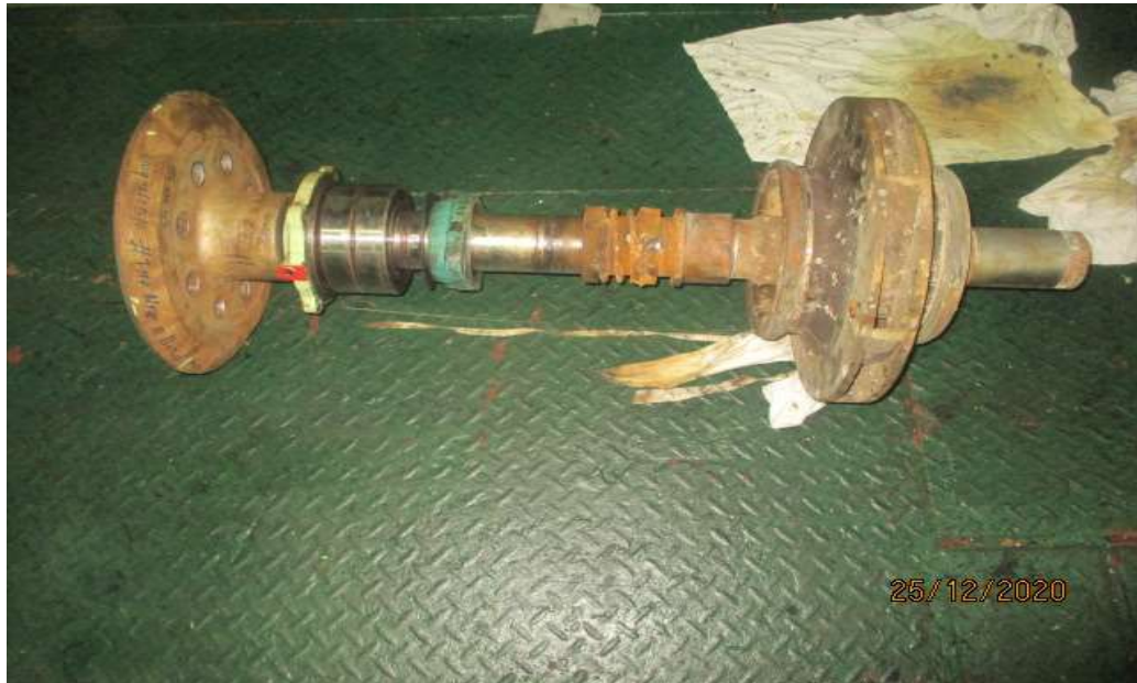
Lampiran 15. Korosi Yang Terjadi Pada Sahft Pompa Air Laut
