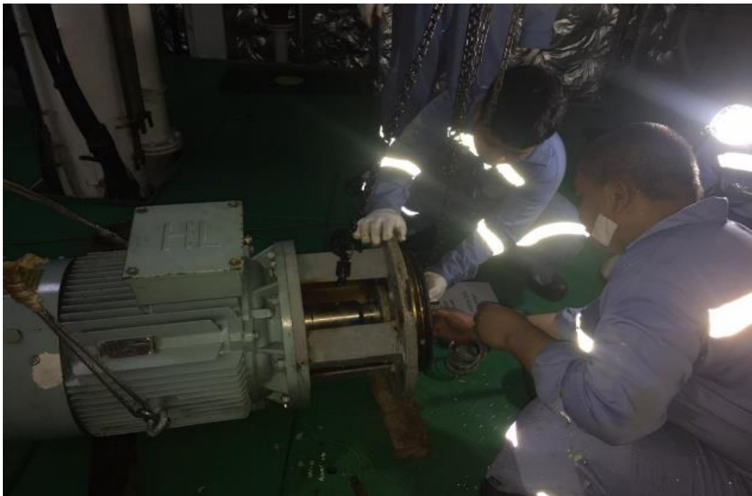
Pengerjaan pompa air laut AE
