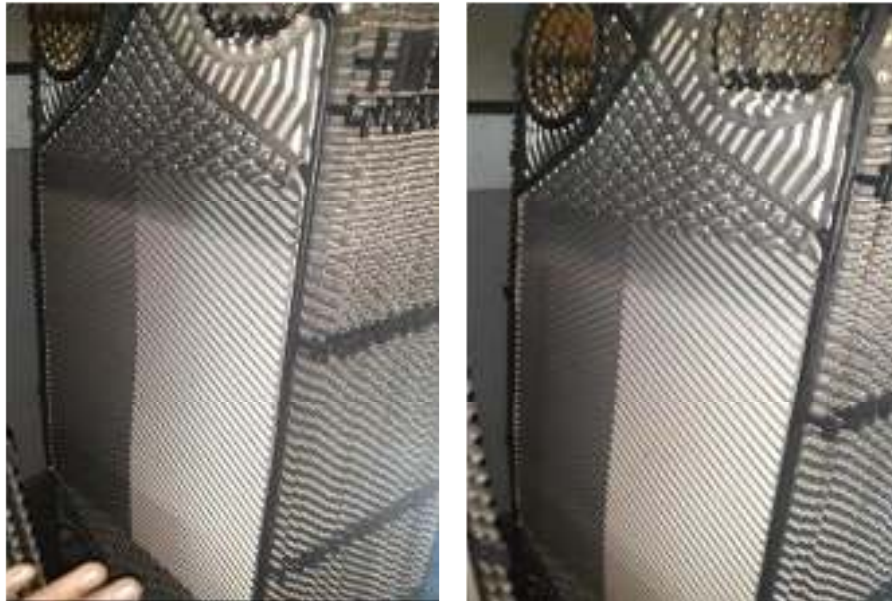
Gambar 3.8 : Penyusunan Kembali Channel Plates setelah selesai Dibersihkan
