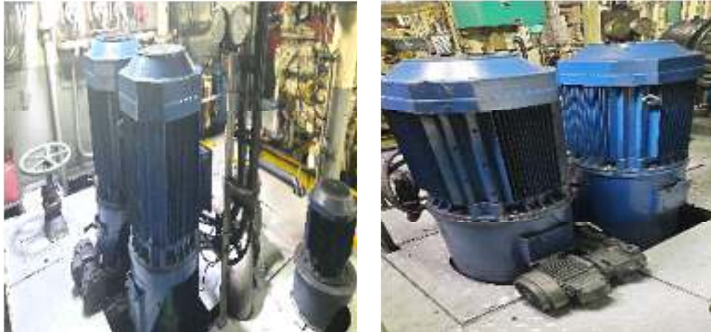
Gambar 3.2 : pompa air laut no 1 dan 2
