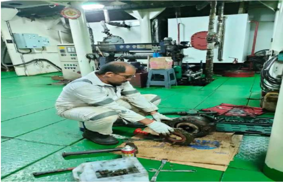
Gambar 3.3. Pemeriksaan kondisi pompa pendingin mesin induk.
