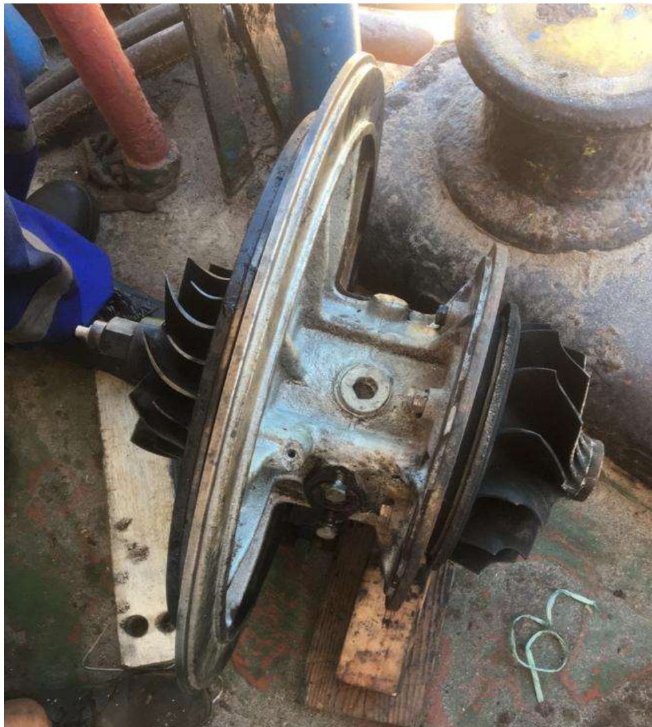
Sumber : Foto Engine Room MT. EDRICKO 8
