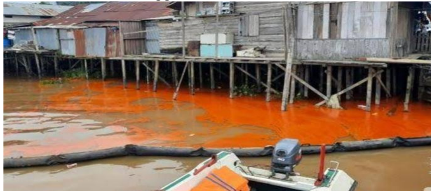
Gambar 1.2 Mengumpulkan Tumpahan Minyak Menggunakan Oil Boom
