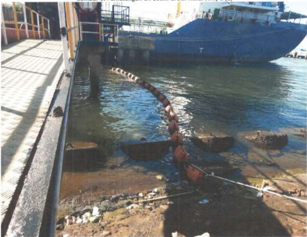
Gambar 4. Pemasangan Oil Boom di Sisi Timur Jetty 2 (2)
