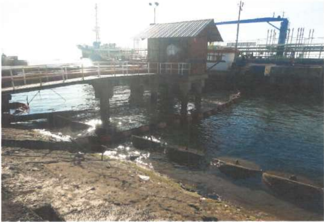
Gambar 3. Pemasangan Oil Boom di Sisi Timur Jetty 2 (1)
