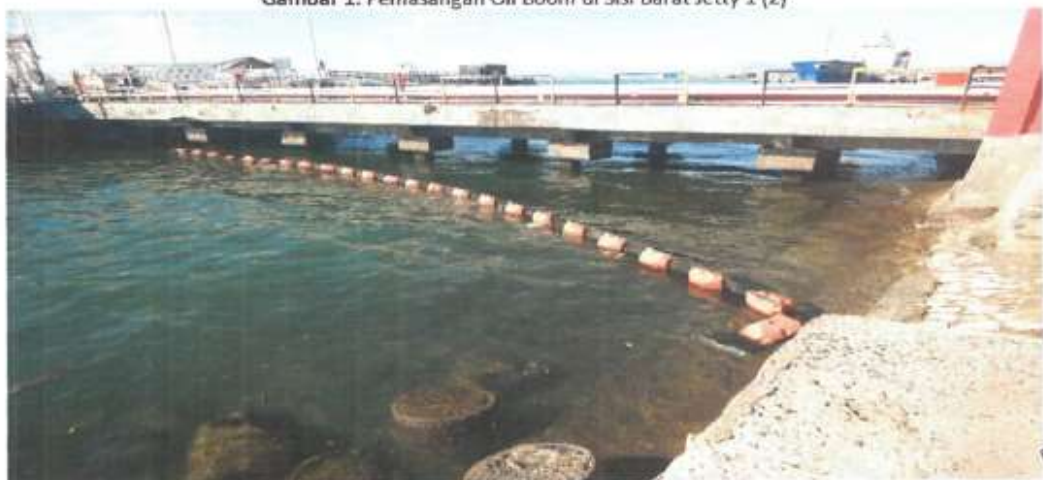
Gambar 2. Pemasangan Oil Boom di Sisi Barat Jetty 1 (2)
