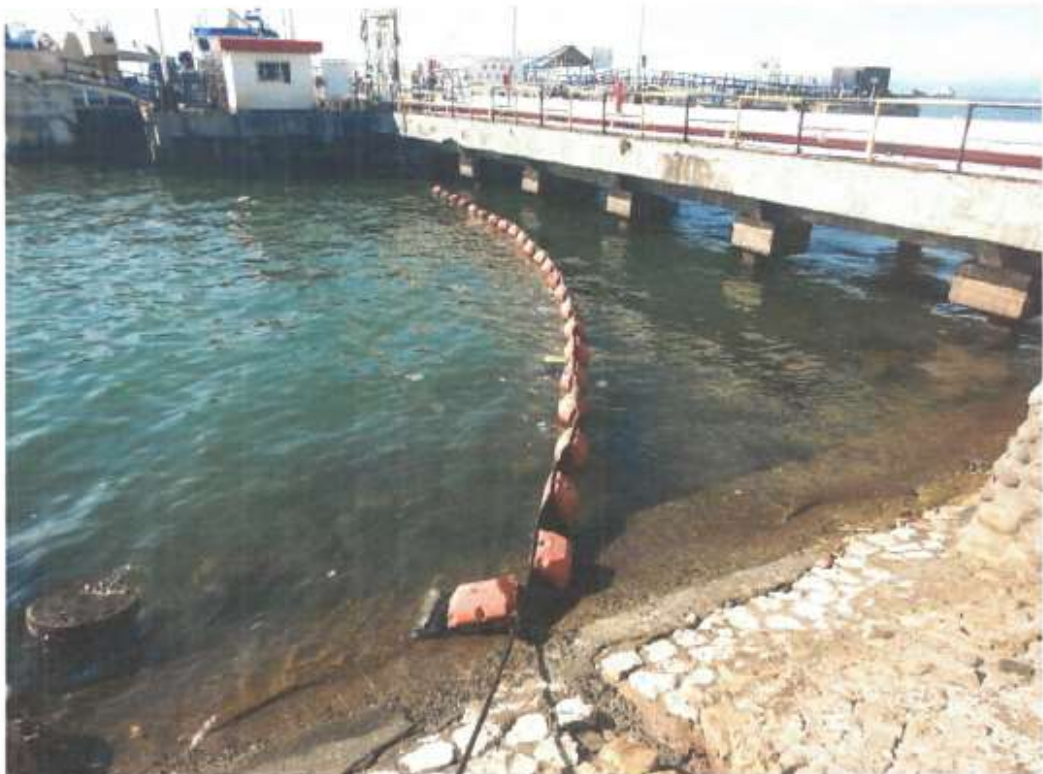
Gambar 1. Pemasangan Oil Boom di Sisi Barat Jetty 1 (2)
