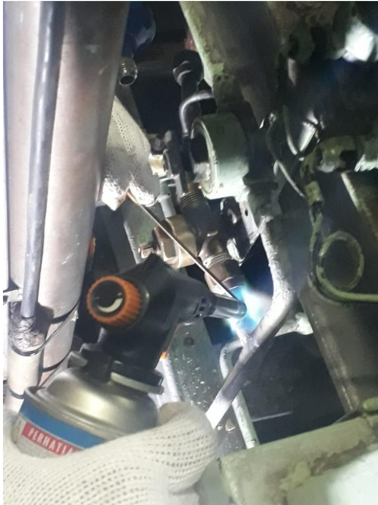
Lampiran 1 Pengelasan Kebocoran Pada Pipa Refrigerator
