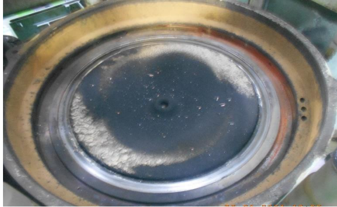
Gambar pengecekan dan perbaikan pada piston
