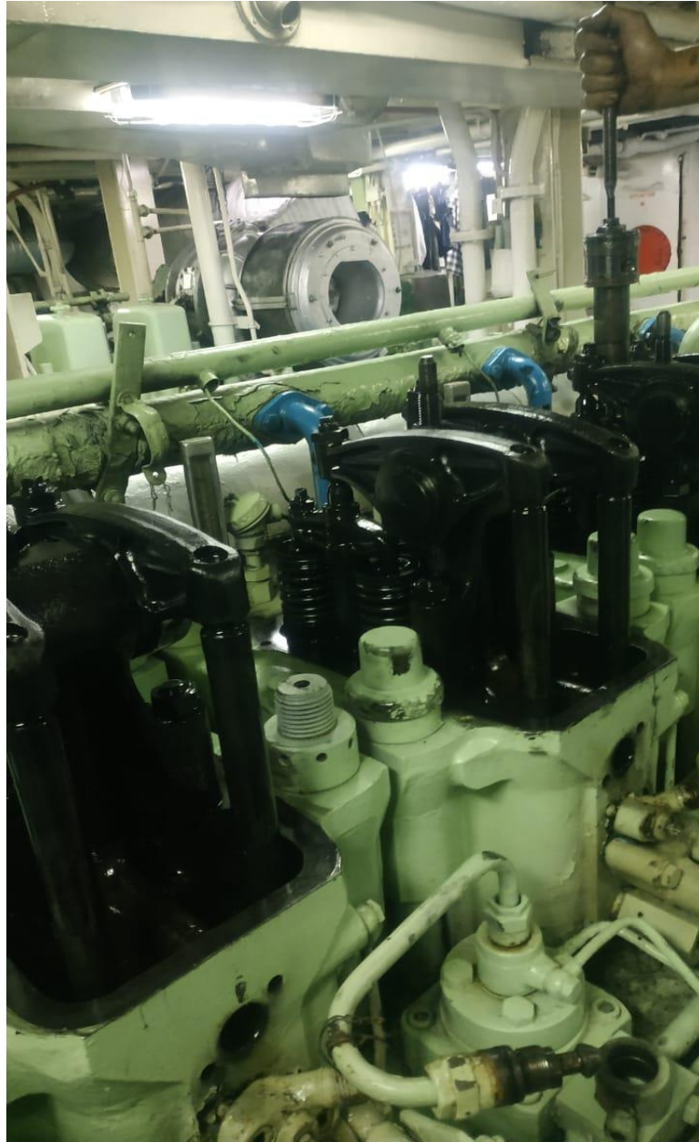
Gambar: Proses Perbaikan Injektor
