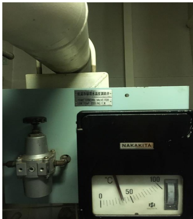
Gambar 4. 5 Thermostat MT. Aspire
