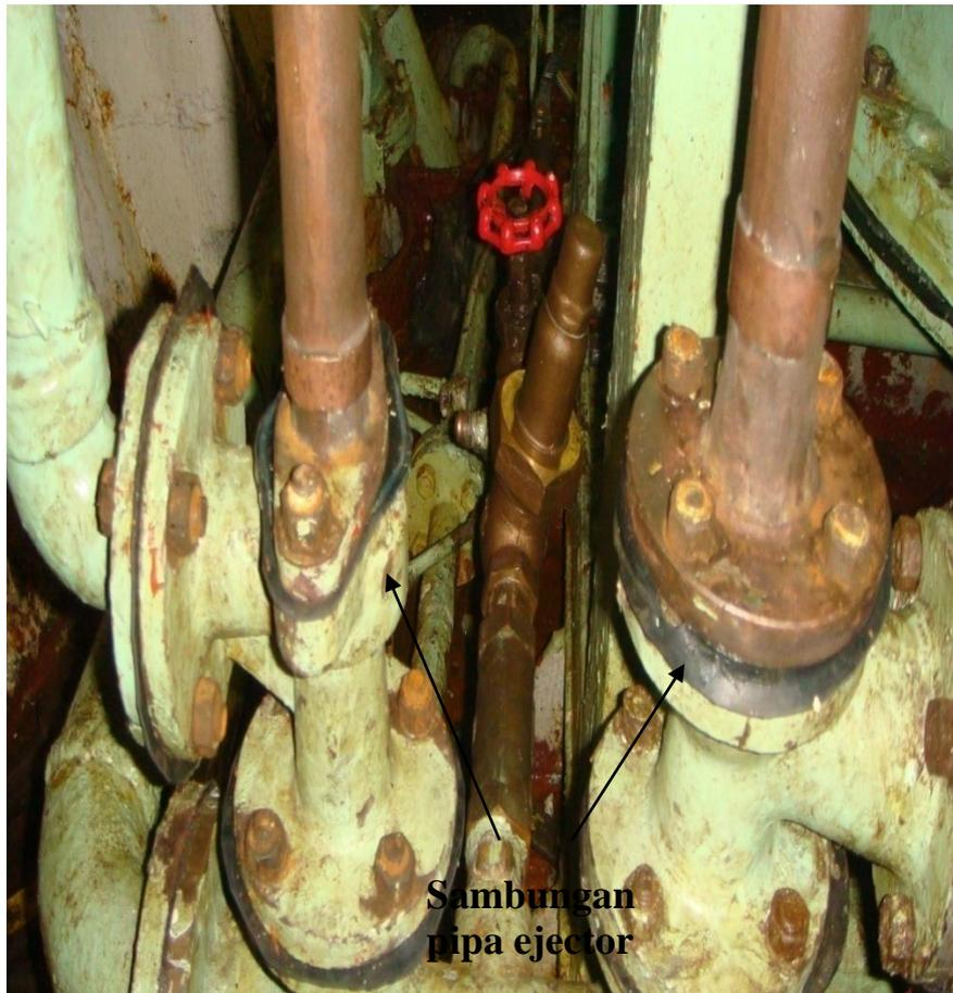
Gambar 5 Sambungan Pipa Ejector Dengan Evaporator Sheel
