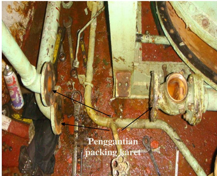
Gambar 6 Penggantian Packing Karet Pada Pipa-Pipa
