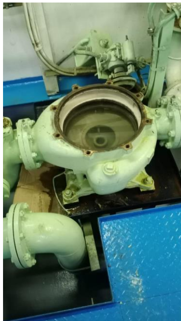
Gambar : perbaikan pompa sentrifugal
