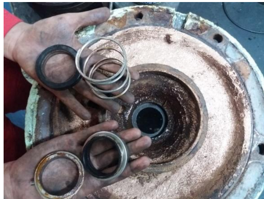
GAMBAR 4. 3 kondisi dari mechanical seal pompa yang sedang diperbaiki
