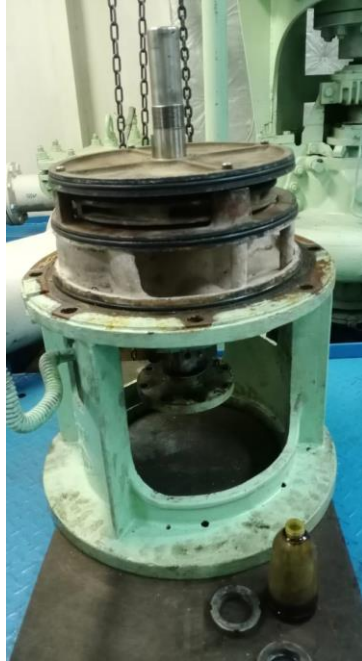
Gambar : perbaikan pompa sentrifugal
