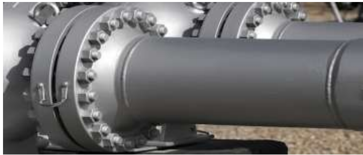
Gambar 2.13 Penyambung pipa ( flange )
