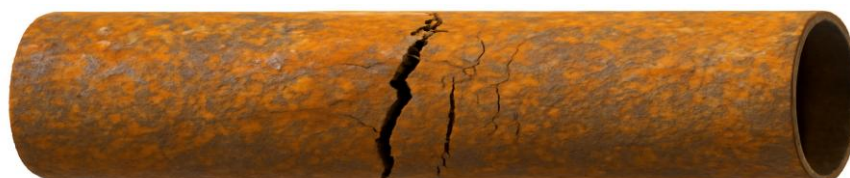
Gambar 2. 7 pipa korosi lelah
