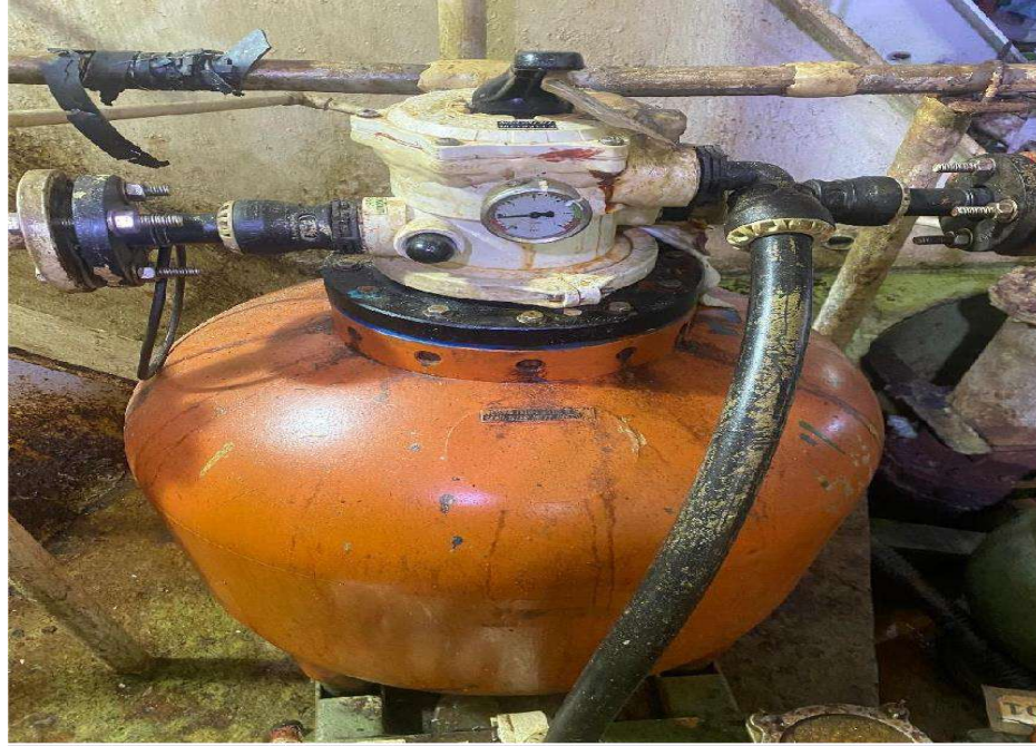
Gambar 2. 6 Sandfilter MT. Sengeti Sumber: Dokumentasi Pribadi MT. Sengeti
