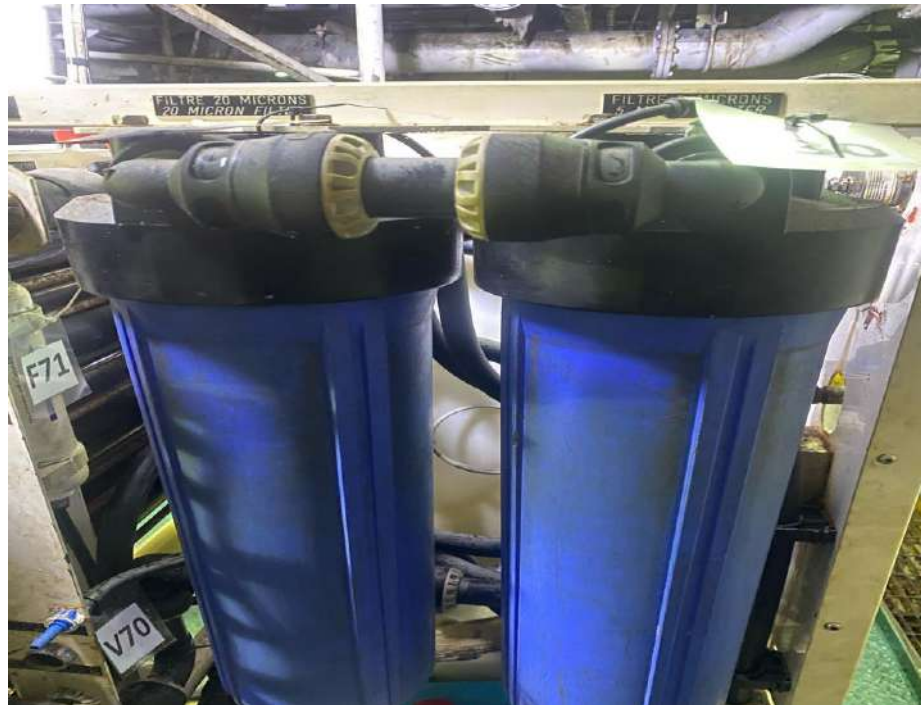
Gambar 2. 8 Cartridge Filter Sumber: Dokumentasi Pribadi MT. Sengeti
