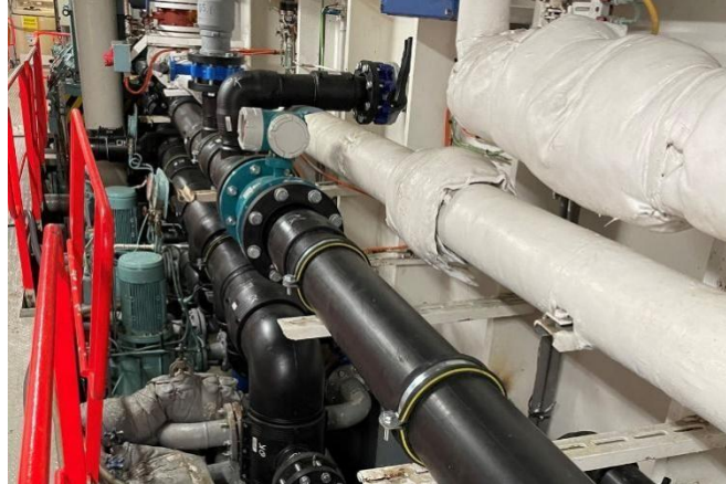
Gambar 2.2 Sistem Perpipaan dan Pompa
