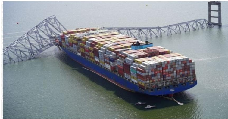
Jembatan Baltimore yang ambruk. Foto: REUTERS/Maryland National Guard
