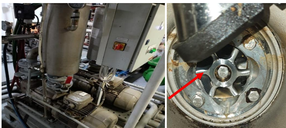
Gambar 2.2 Vacuum Pump Unit (kiri) Macerator (kanan)
