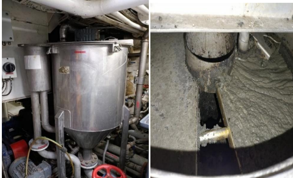
Gambar 2.14 DAF Unit Tampak Keseluruhan (kiri), Penampakan dalam DAF Unit (kanan)
