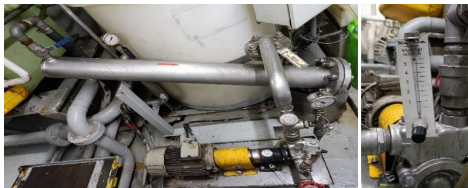
Gambar 2.13 Dispersion Unit & Pump (kiri), Airflow meter/Rotameter (Kanan)
