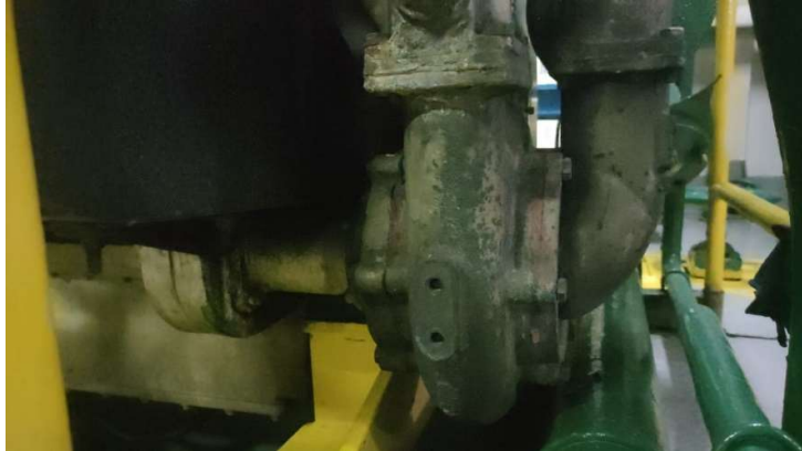
Gambar 2.3 Pompa Sirkulasi Air Laut
