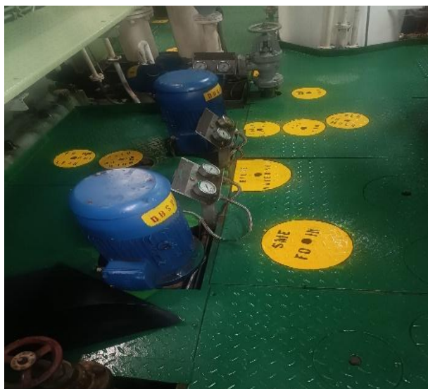
Gambar 2.3 Pompa Sirkulasi
