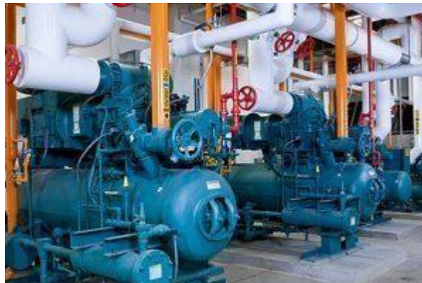
Gambar 2.2 Kompresor Pendingin
