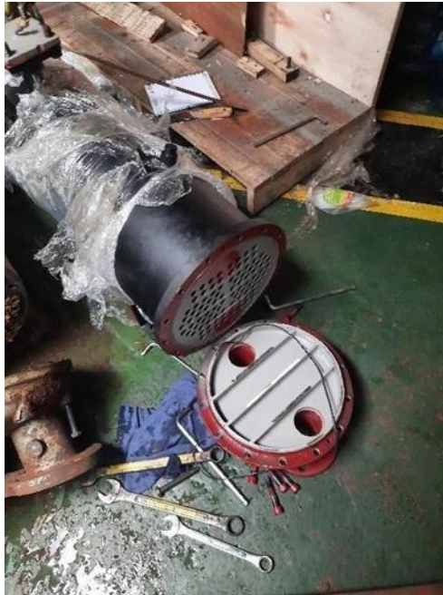
Gambar 4.6 Kondensor AC Central Baru
