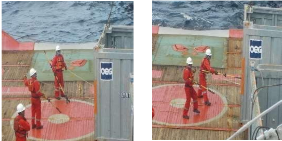
Gambar 2.3 Personil Mengontrol Cargo Dengan Menggunakan Stiffy dan Tag Line
