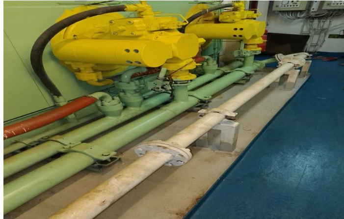
Gambar 2.2 : hydraulic pump penggerak tenaga mesin diesel
