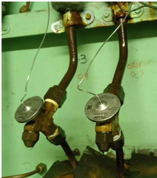
Gambar 2. 6 Katup Ekspansi Manual
