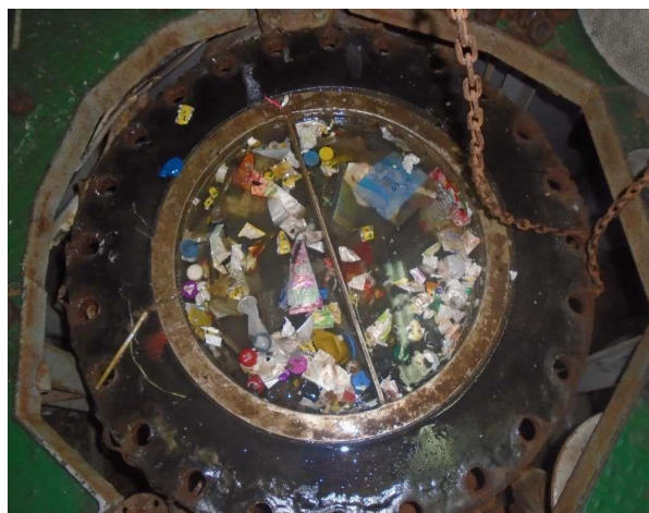
Gambar : 2.6 Kotoran pada strainer
